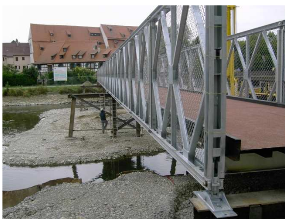
Widerlager und Mittelstütze
