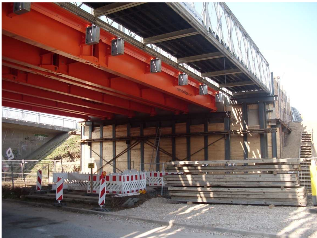
Widerlager (Trägerbohlwand) für die Auflagerung der Behelfsbrücken
