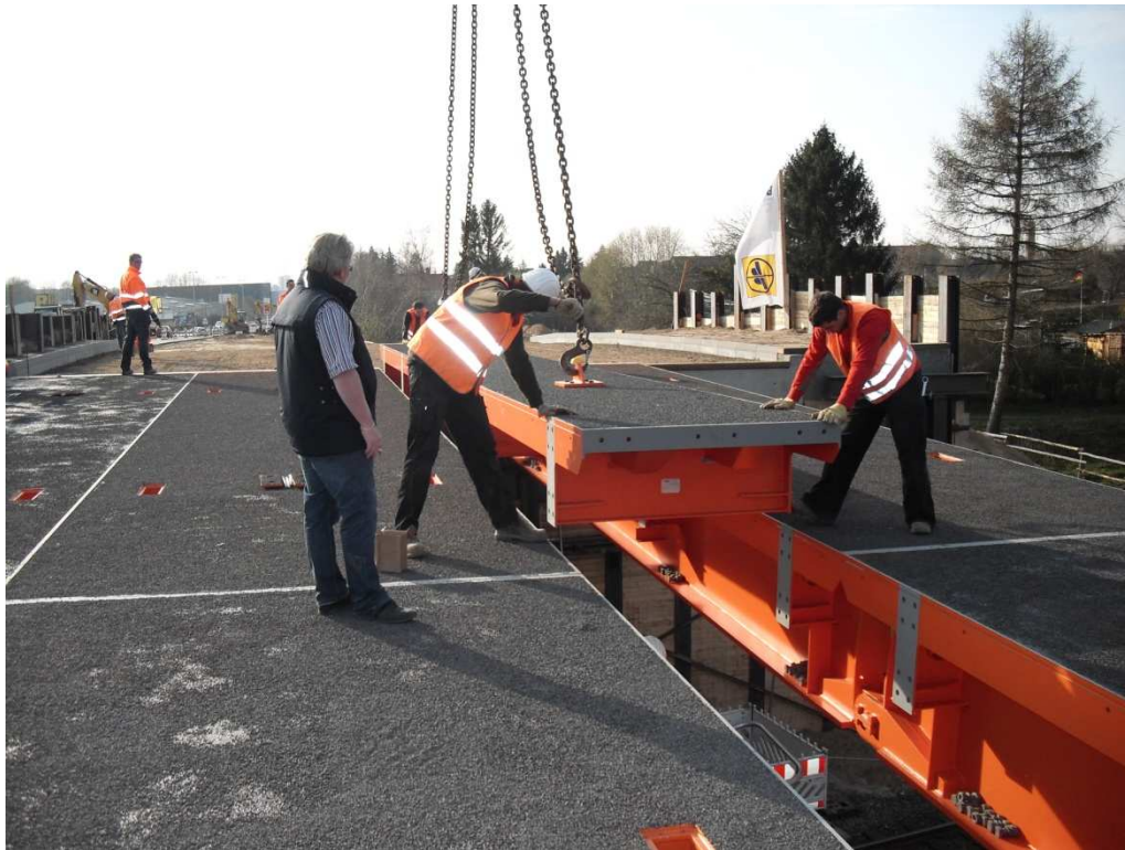
Montage der Brückenteile – hier RLB-Zwischenelement
