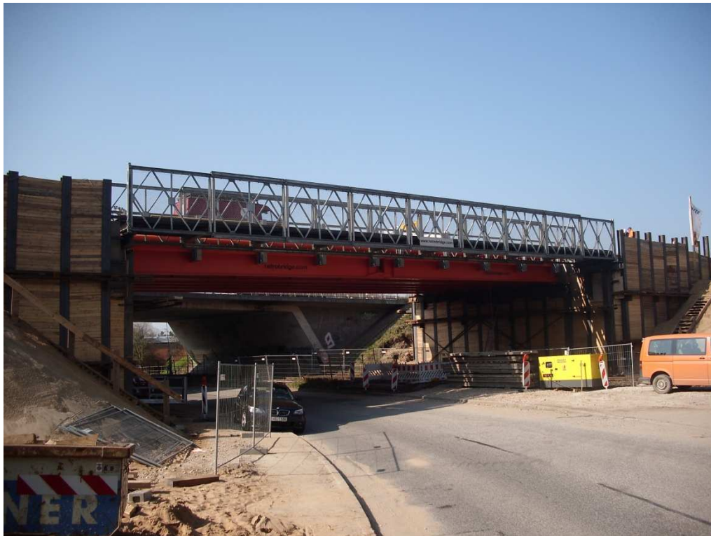
Ansicht der Behelfsbrücken (RLB + C200)
