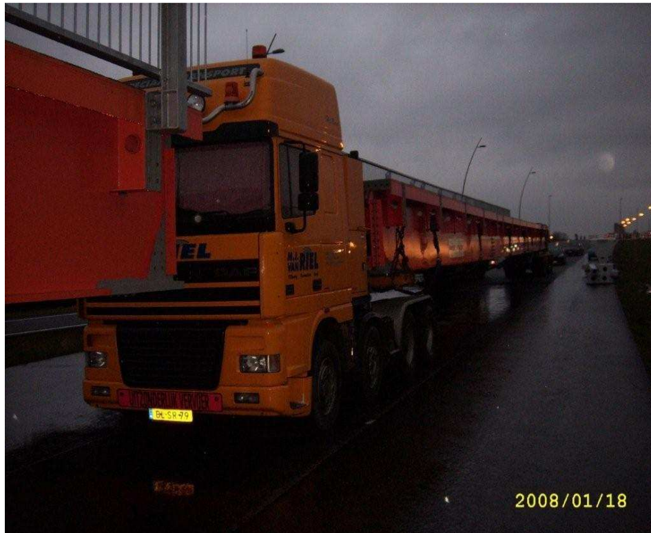
Vormontierte RHB-Brücke mit 40,50 m Länge und 3,00 m Breite
