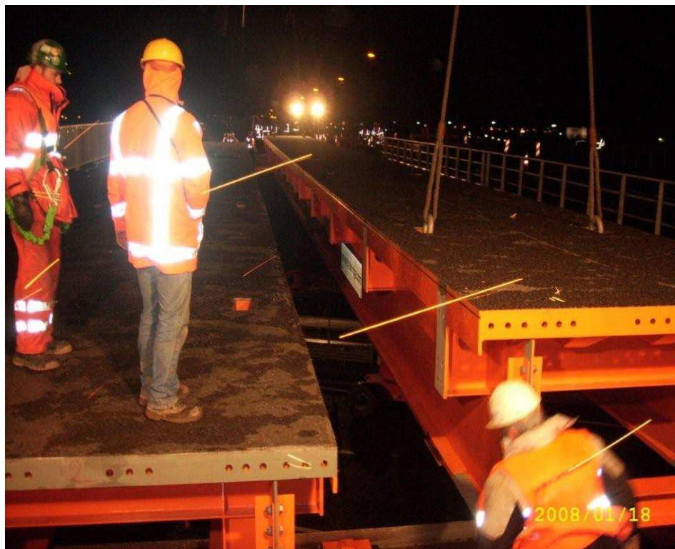
Einheben der Brückenteile im Tandemhub
