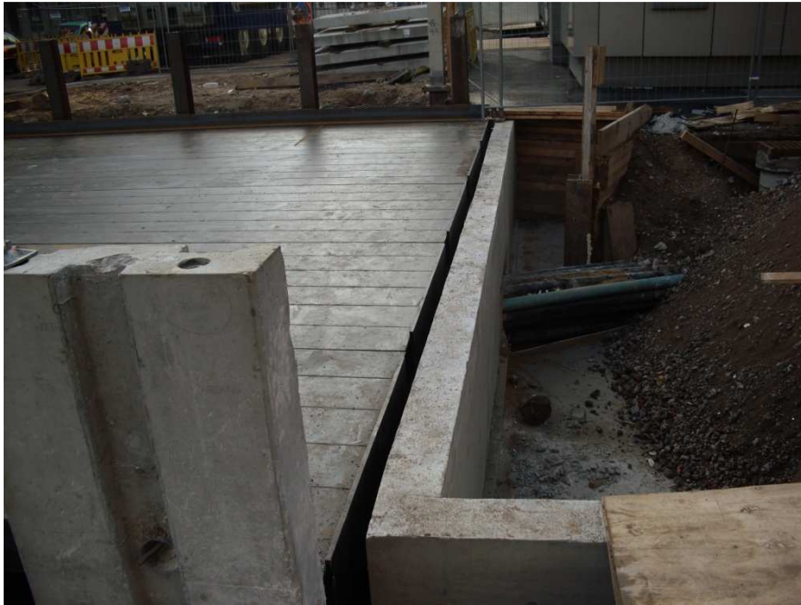
Widerlager der Behelfsbrücke mit Leitungspaket unter Brücke
