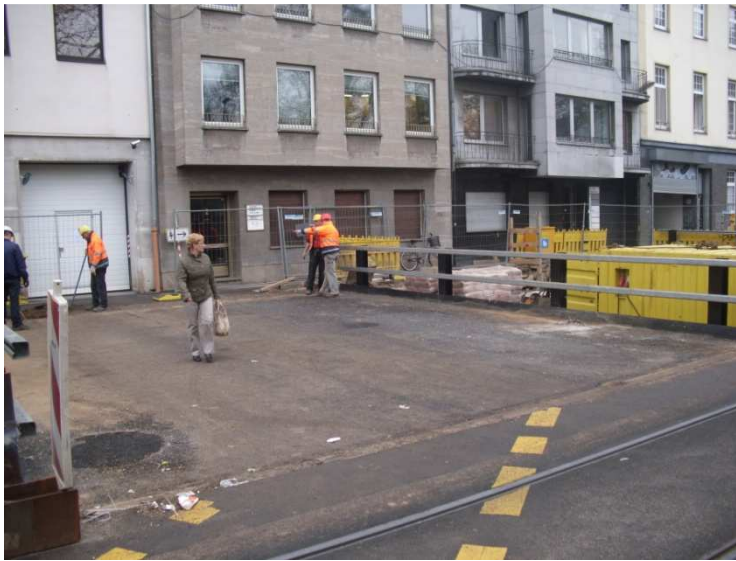
RBB-Brücke – hier 10,50 x 8,70 m mit Geländer
