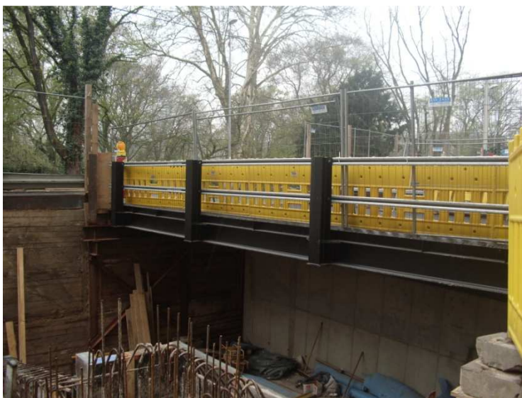
Brücke über Tunnelbaugrube (Bauhöhe nur 350 mm)
