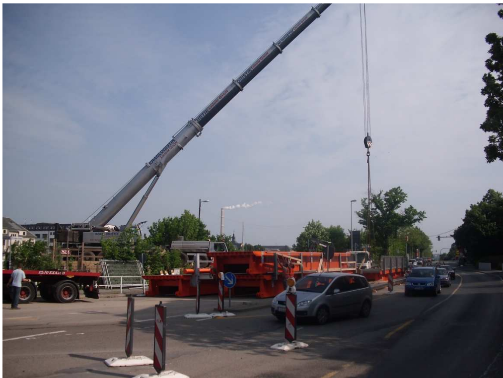
Vormontage der Brücke hinter einem Widerlager bei laufendem Verkehr
