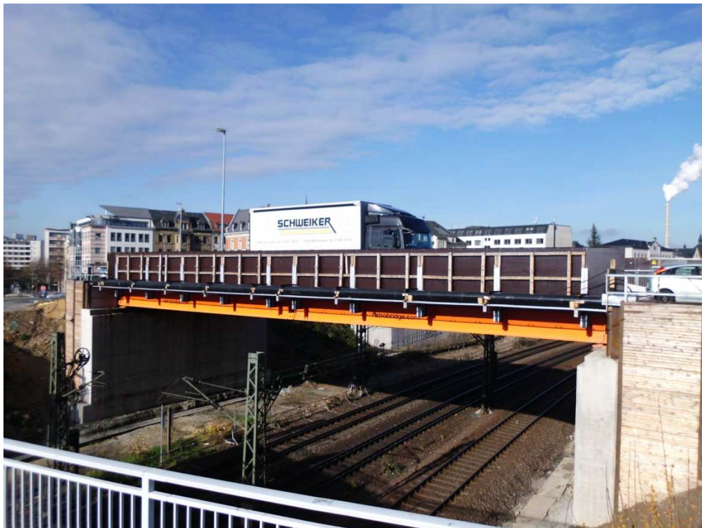
RLB-Behelfsbrücke über der 3-gleisigen DB-Strecke in Chemnitz
