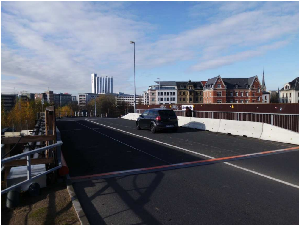
RLB-Brücke – Länge 27,00 m, lichte Breite 12,00 m
