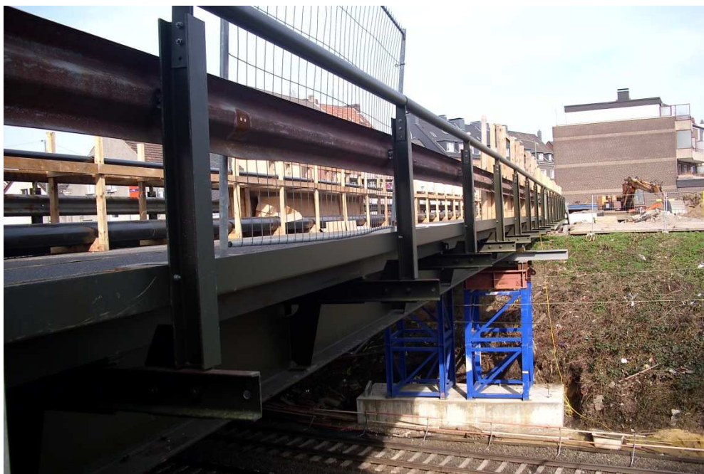
RFB-Brücke, Länge 50,00 m mit Mittelstütze über der DB-Strecke
