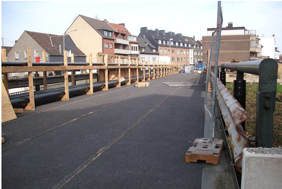
Fahrbahnbreite 6,0 m für Leitungen + 1-spurigen Verkehr + Fußgänger
