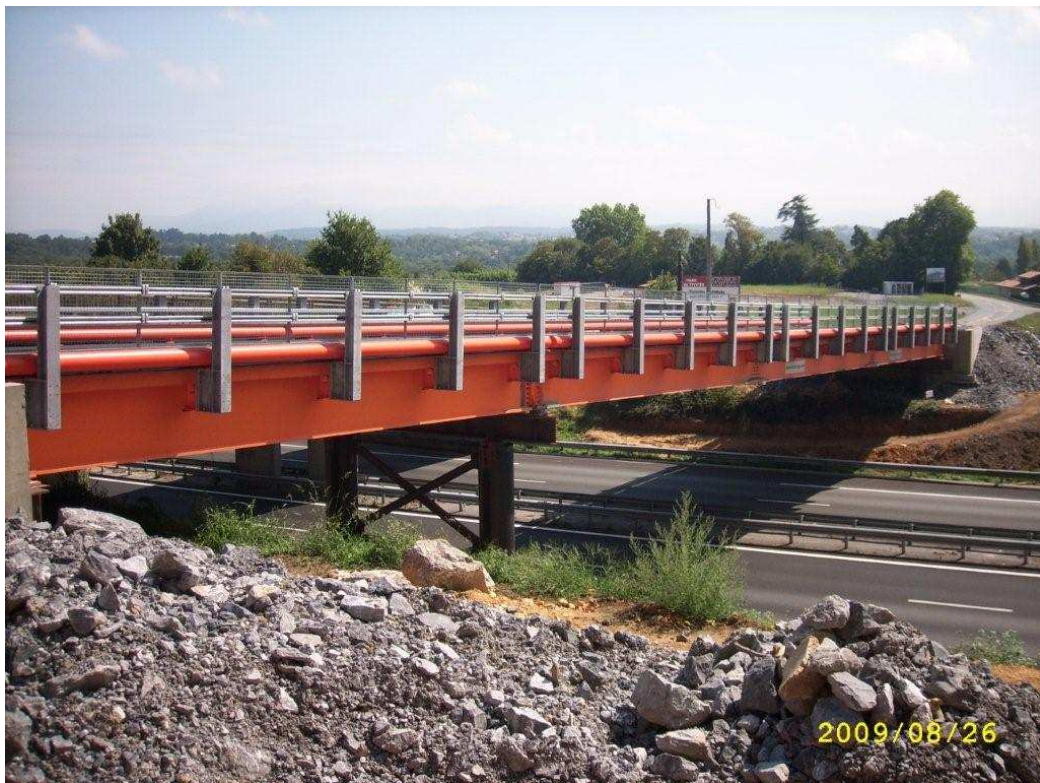
Ansicht der RHB-Brücke mit Mittelstütze außerhalb der A 63
