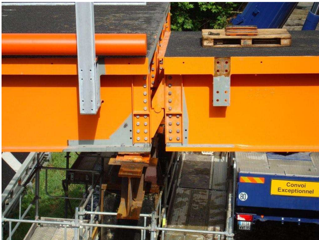
Koppelstelle des RHB-Brückensystems über der Mittelstütze
