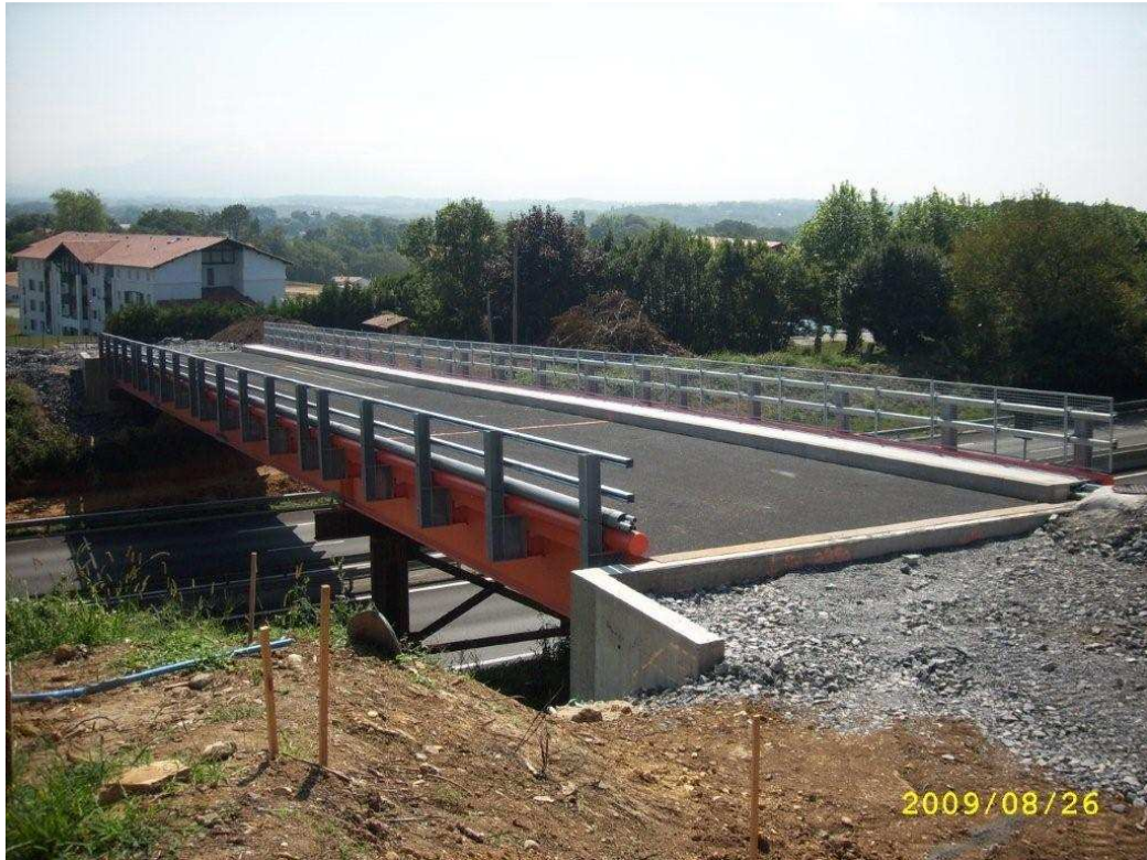
RHB-Behelfsbrücke – 2-Feldbauwerk (40,50 m + 13,50 m) x 7,50 m
