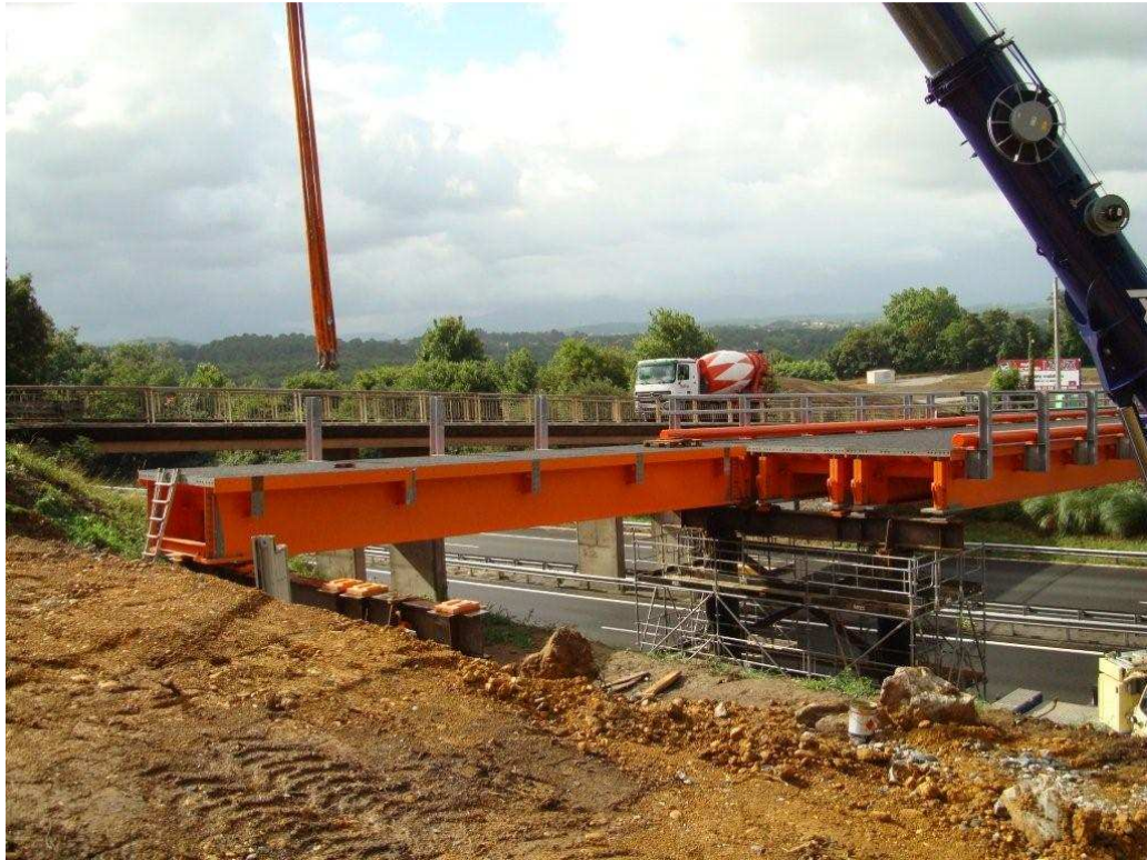
Montage des gelenkig gekoppelten Brückenfeldes mit 13,50 m Länge
